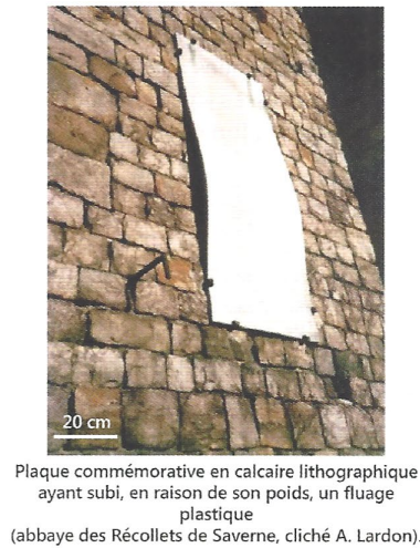
▲ FIGURE 27. Diagramme contrainte-déformation dans le cas d'un fluage à contrainte constante et cliché d'une plaque calcaire fluante . D'après DAUTEL et al. (2021)
