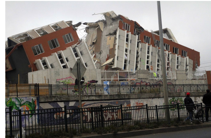
▲ FIGURE 3. Un immeuble, construit sur des sédiments meubles, fracturé et effondré suite à un séisme (Chili, 2010). D'après Wikipédia (janvier 2022).
